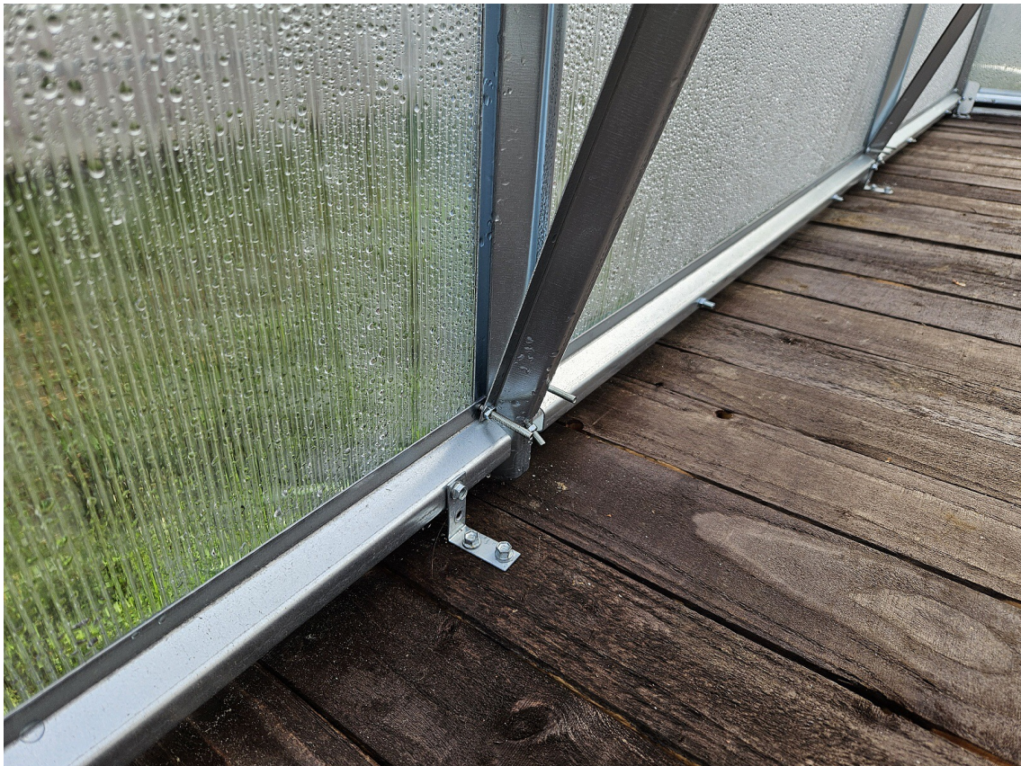
CZ - ilustrativní foto způsobu montáže podpěry (model LUCIUS má na na každé straně pouze dvě podpěry) SK - ilustratívne foto spôsobu montáže podpěry (model LUCIUS má na na každé strane iba dve podpěry) HU - szemléltető fotó a merevítő profil beépítéséről (a LUCIUS modell mindkét oldalon csak két merevítő profillal rendelkezik)
